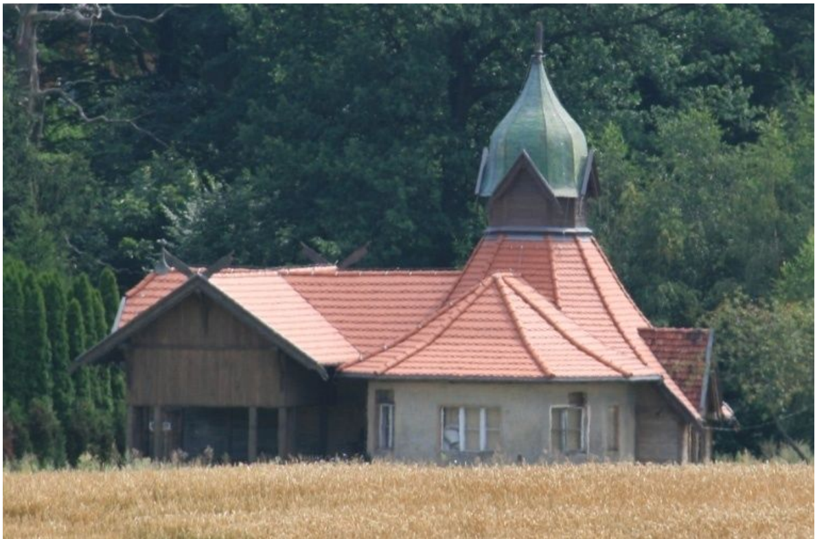
Fot. nr 13. Budynek dawnego dworca w Budwitych. Widok od strony zlikwidowanej linii kolejowej. Zb. Woś. 2016 r.
