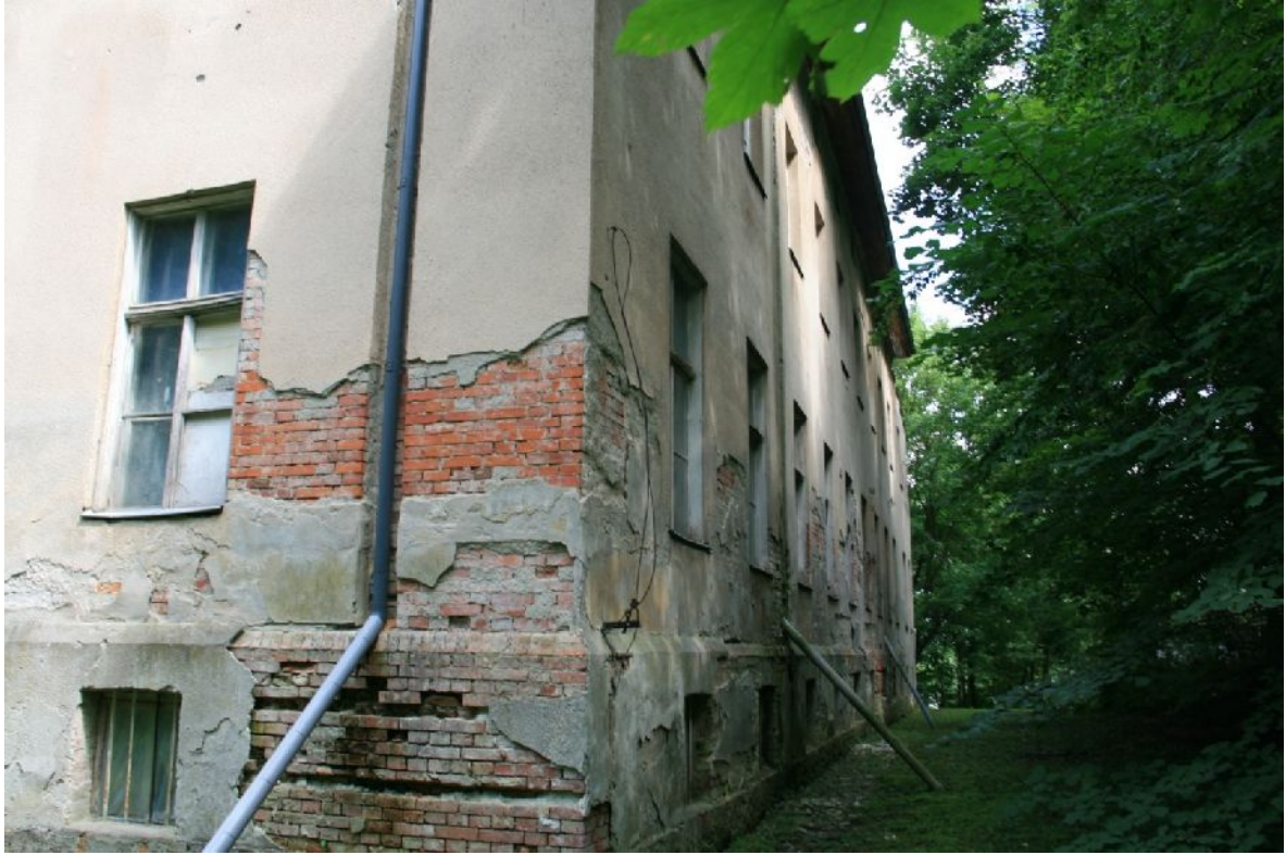
Fot. nr 6. Elewacja południowa pałacu z jedenastoma otworami okiennymi na każdej kondygnacji oraz fragment elewacji zachodniej. Zb. Woś. 2016 r.
