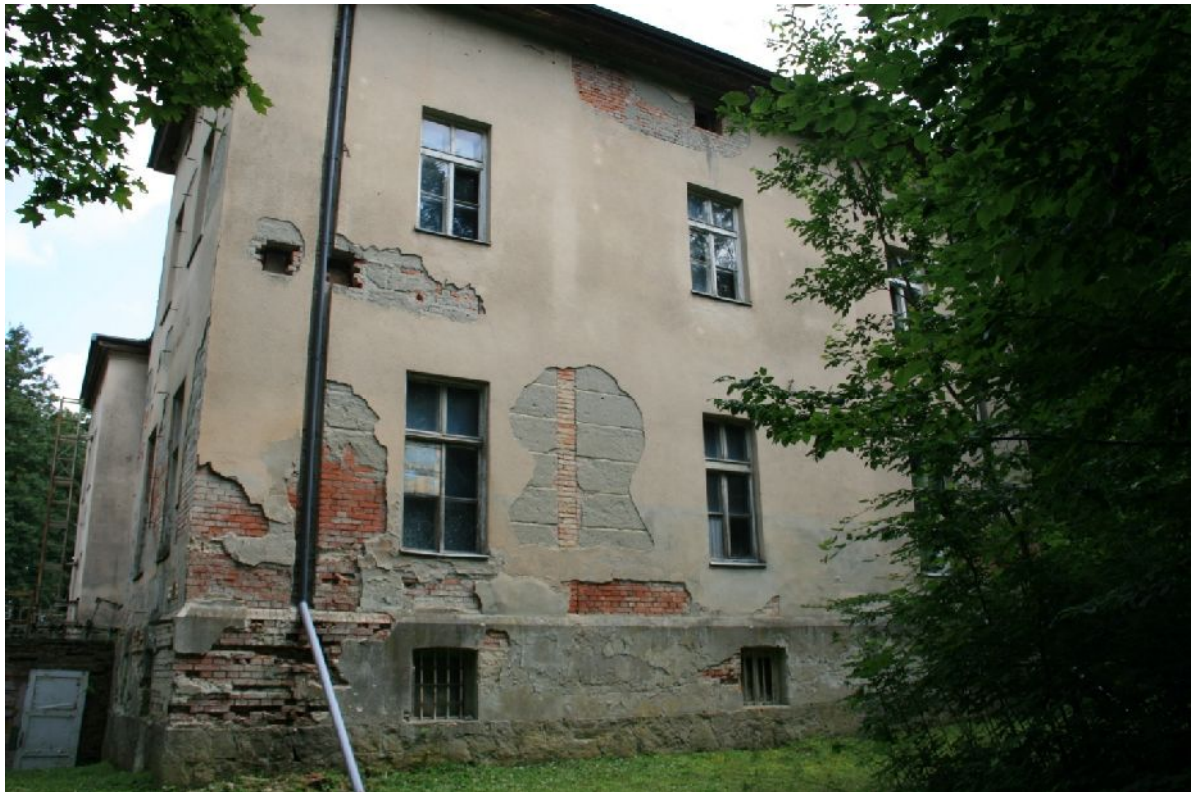
Fot. nr 7. Elewacja zachodnia pałacu w Budwitych. Widoczne wysokie podpiwniczenie z fundamentem kamiennym oraz odkryty boniowany tynk pierwotny na elewacji. Zb. Woś. 2016 r.
