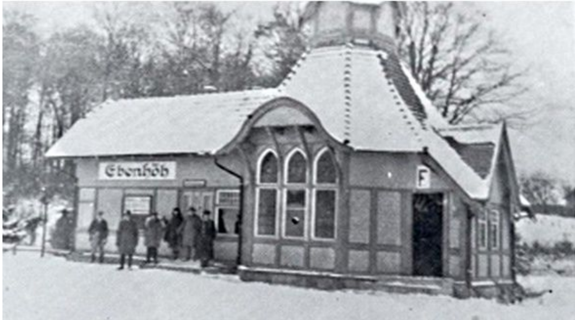
Fot. nr 11. Budynek dworca w Budwitach (Ebenhöh) po przeniesieniu go z Prakwic. Stan z roku ok. 1920. Autor nieznan
